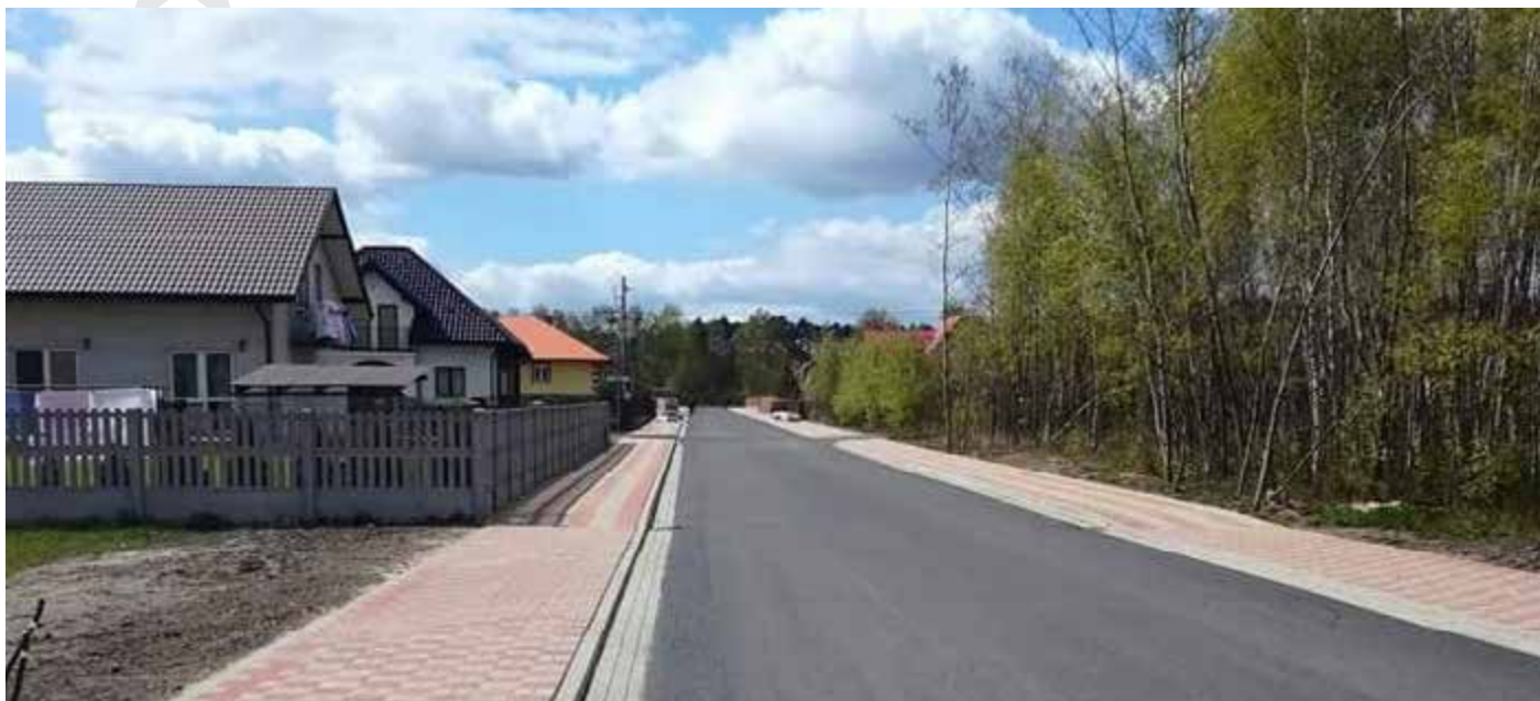
Przebudowana droga gminna w Brzezinach (powiat kaliski) została oddana do użytku w kwietniu 2017 r. Gmina otrzymała na to zadanie 218 528 złotych ze środków PROW na lata 2014-2020.
