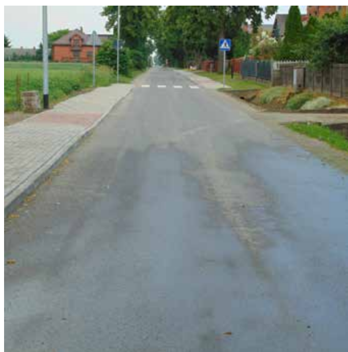
Przebudowana droga gminna Szczytniki-Kobylarka w gminie Szczytniki (powiat kaliski). Inwestycja została dofinansowana ze środków PROW w kwocie ponad 300 tysięcy złotych.
