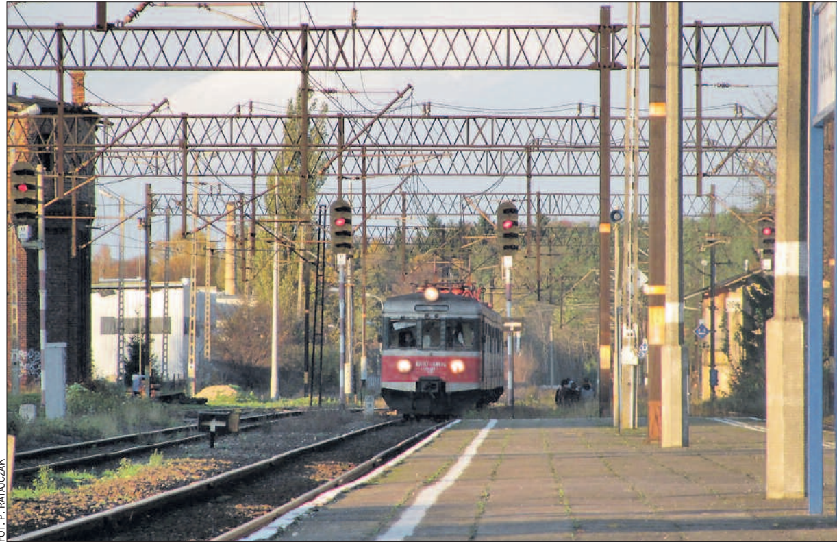
Wśród potencjalnych projektów kluczowych WRPO 2014+ wymienia się linię kolejową z Poznania do Piły. Obecnie tory na niektórych odcinkach są tak zdewastowane, że pociągi zwalniają do 20-30 km/godz.
