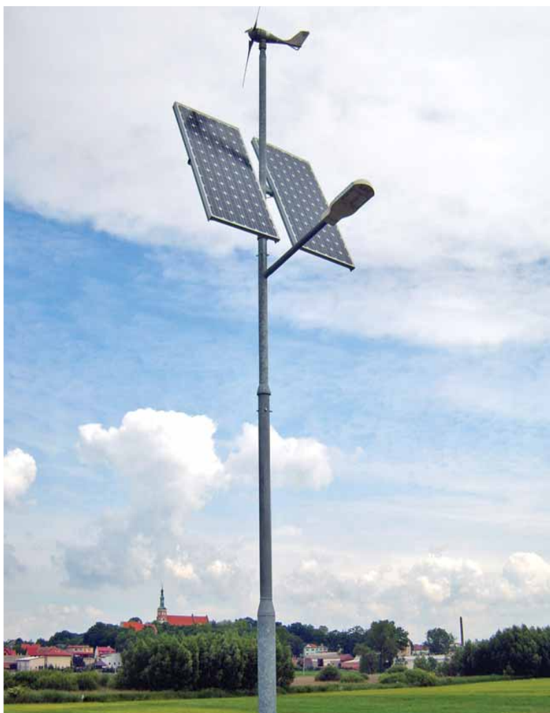
W podkrzywińskich wsiach punkty świetlne zainstalowano w miejscach oddalonych od istniejącego oświetlenia drogowego
