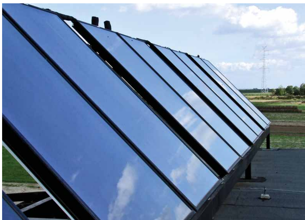
Kolektory słoneczne na dachu Szkoły Podstawowej w Borzęcicach
